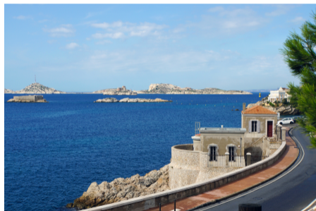
Marégraphe de Marseille (promenade de la corniche).
